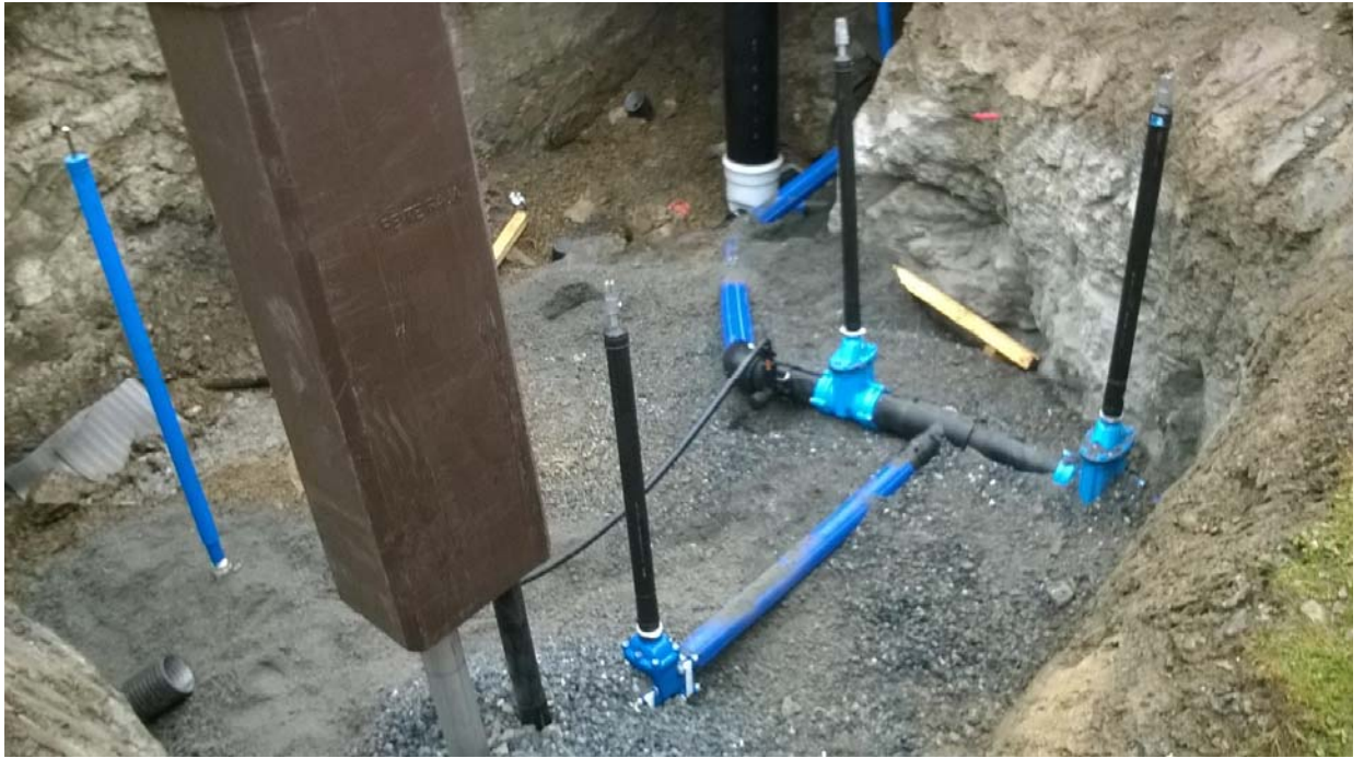
Kuva 9. Viemäri- ja vesijohtoverkoston saneerausta Vainiotiellä.
