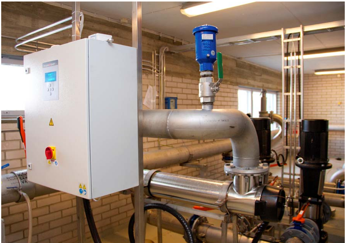
Kuva 5. Vedenottamon UV-laitteisto
