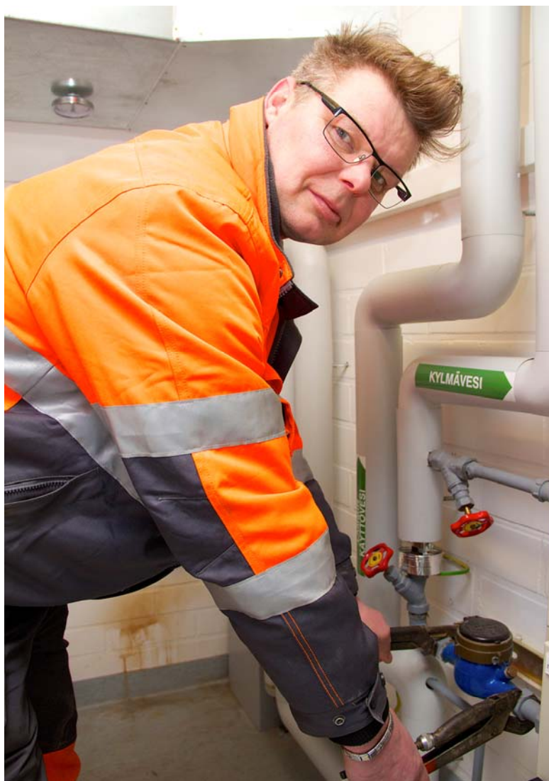
Kuva 4. Vesimittarin vaihtotyötä
